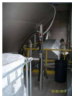
ITR: stazione di ricevimento: tamburo drenante, cono dissabbiatore
