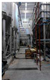
realizzazione 2 nuovi chiarificatori-
